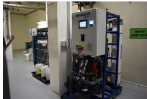
Bazén ČZU Praha
